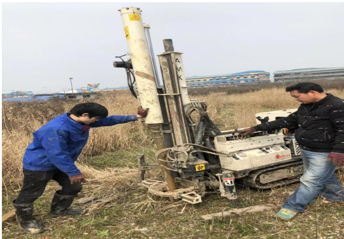
图 5.1-1 土壤采样现场图
